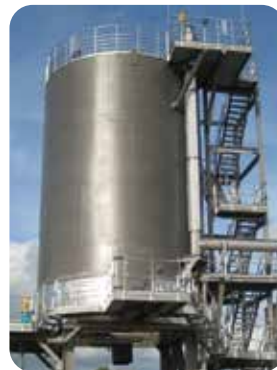
Typische zweistufige Schlammförderer mit vertikalem Hub, die ein Lagersilo beführen
