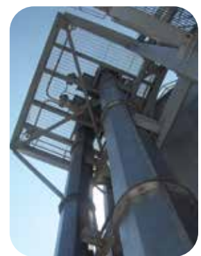
Typische zweistufige Schlammförderer mit vertikalem Hub, die ein Lagersilo beführen
